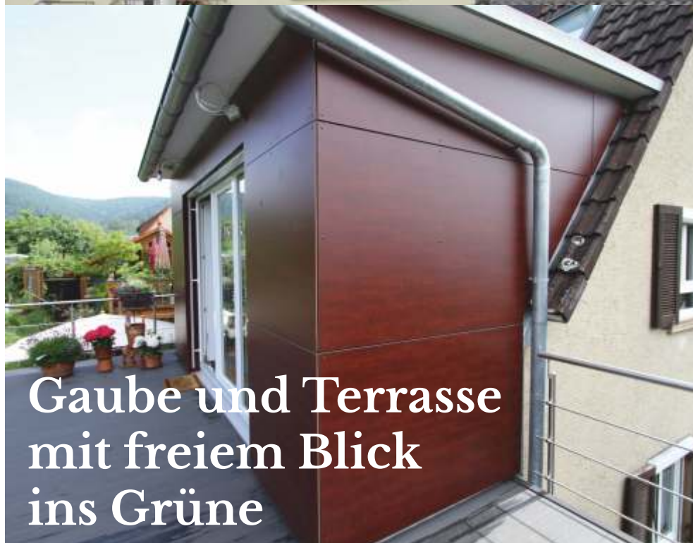
Gaubenausbau mit Bodenverlängerung
